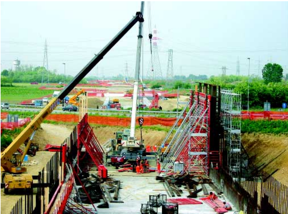
Costruzione della galleria artificiale Rondissone, nel 2003, nell'ambito dei lavori per l'Alta velocità
