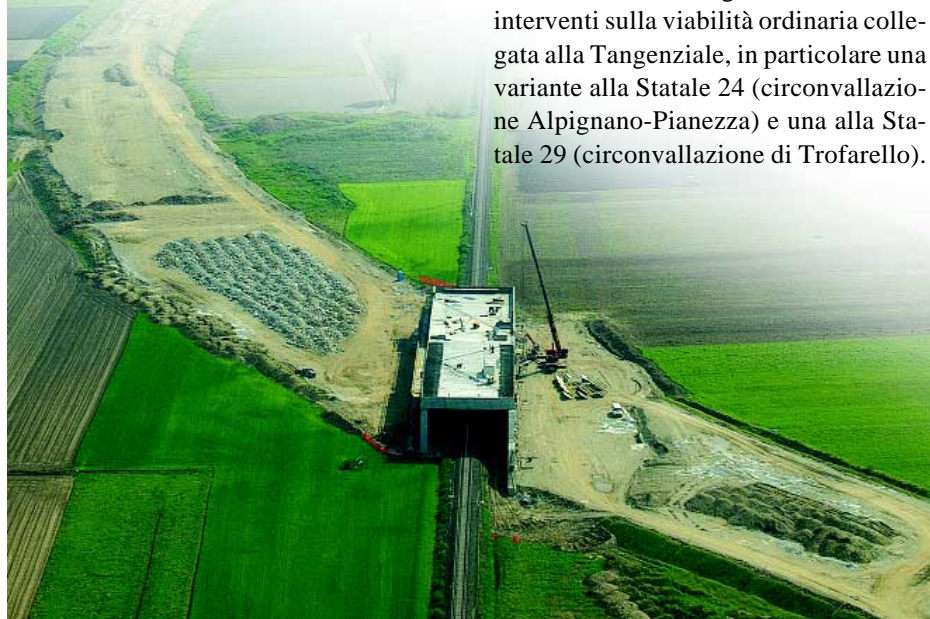
Veduta dei cantieri per la Torino-Pinerolo, nel 2004
