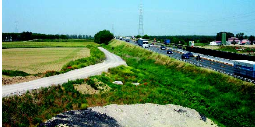
Lavori per l'interconnessione fra A21 e A1, a Piacenza
