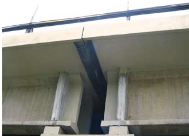
Scossalina in acciaio inox per la raccolta e l'allontanamento delle acque da un giunto
