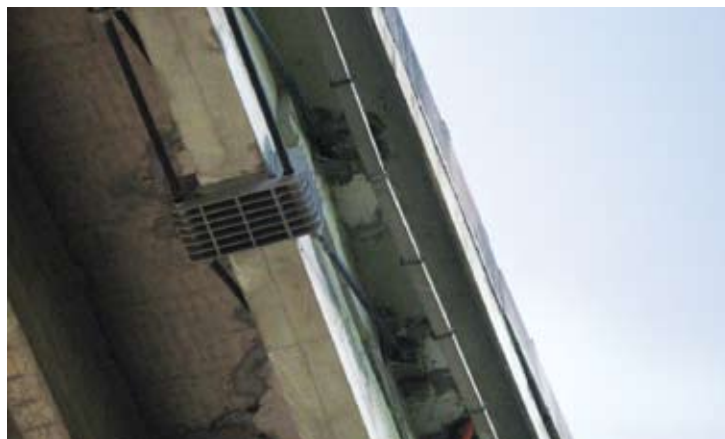
Ripristino della capacità portante di una trave che ha subito il deterioramento dei cavi di precompressione originari attraverso cavi di precompressione esterna
