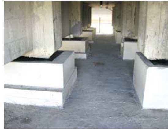
Particolare testa pila di un viadotto su una zona in frana, il cui impalcato è isolato dal terreno inserendo appoggi mobili multidirezionali che consentono ampi spostamenti, provvisti di un sistema di monitoraggio che trasmette i dati in remoto
