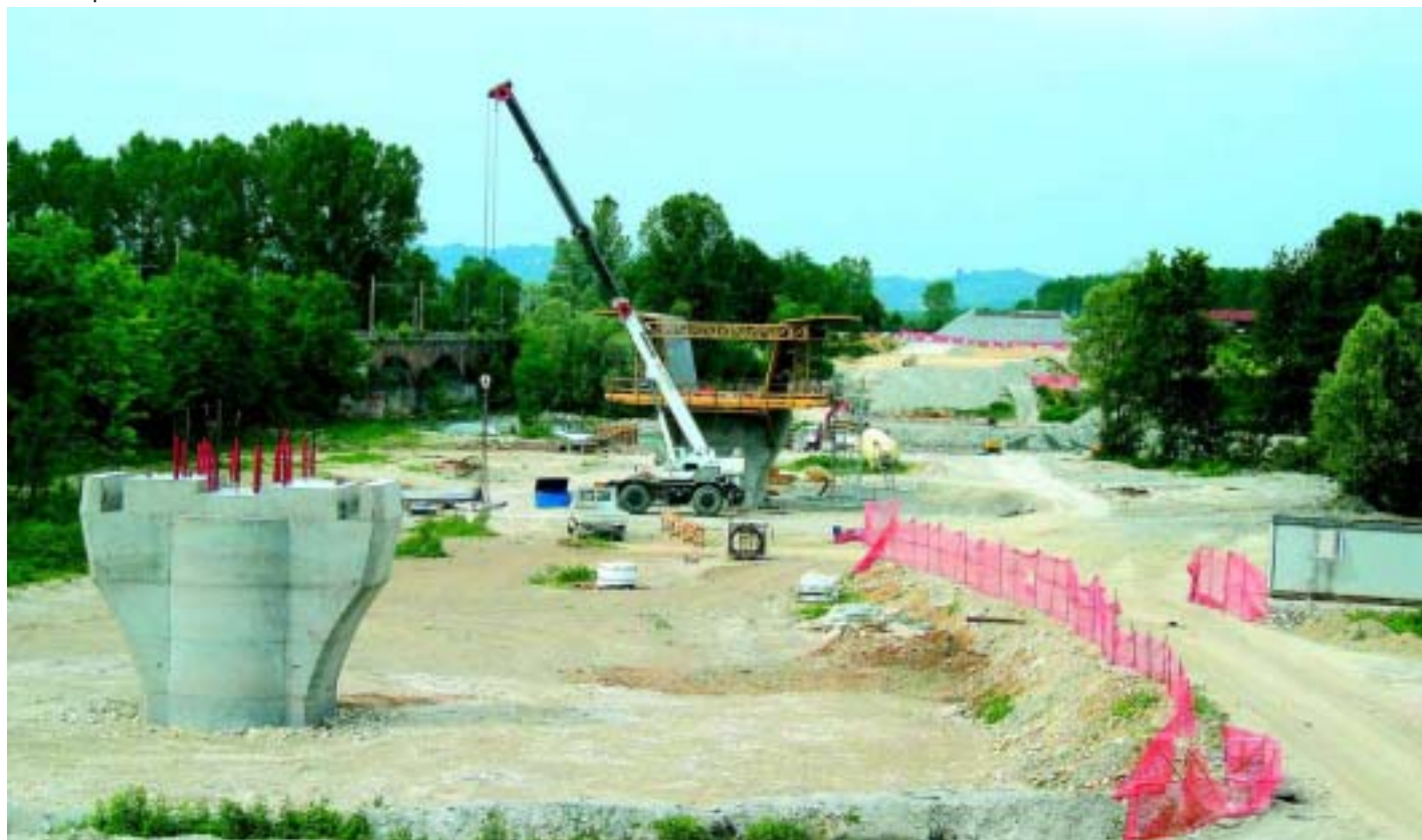
Veduta e particolari del cantiere del viadotto Stura dell'Asti-Cuneo
