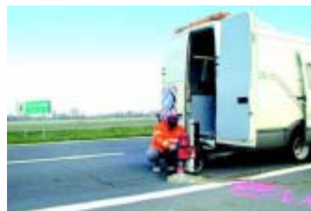
Particolare di uno degli interventi di carotaggio
