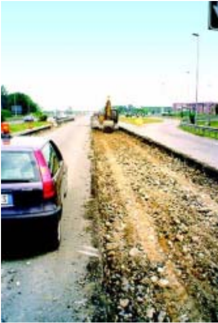
Scavo di uno strato di 15 centimetri della fondazione in misto fiume realizzata negli anni Venti
