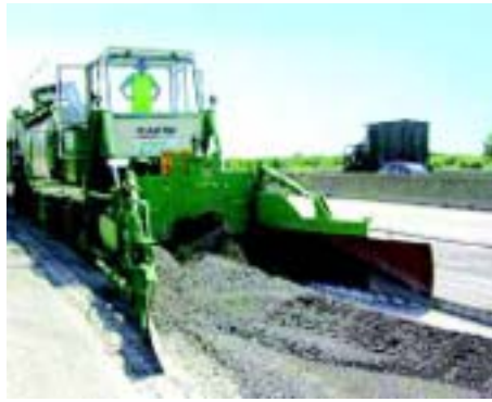
Particolare del caricamento del fresato
