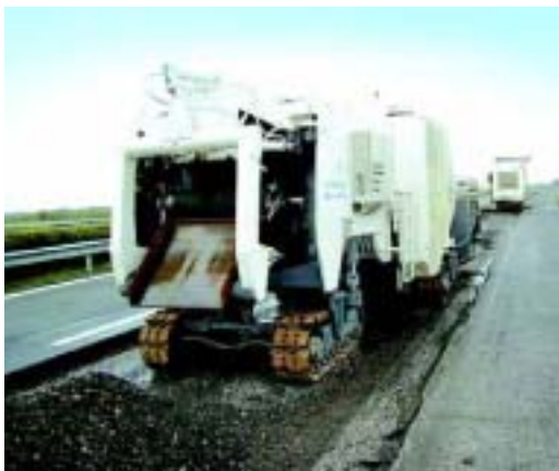
Il frantoio mobile, che raccoglie il fresato e produce la miscela granulata pronta per essere riciclata
