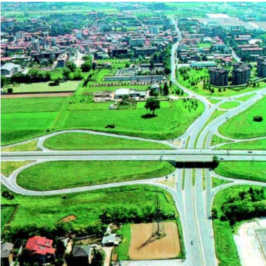
Veduta di un raccordo fra la viabilità ordinaria e quella autostradale
