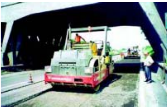
Compattazione dello strato rigenerato dopo la stesa in opera Stesa del conglomerato bituminoso della nuova pavimentazione
