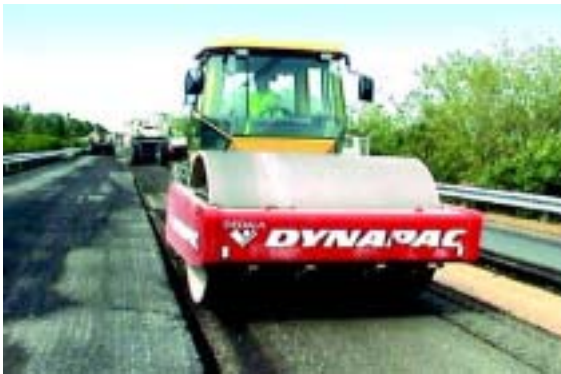
Compattazione del riciclato, che richiede rulli di adeguata capacità sia dinamica che statica
