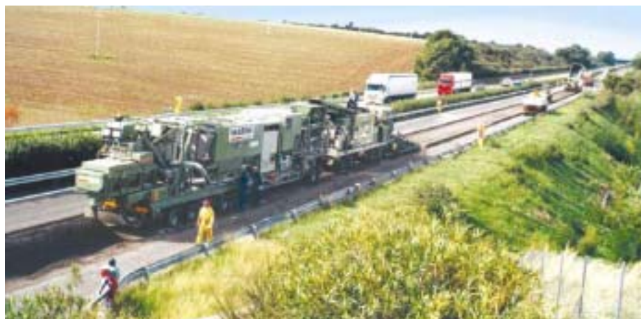
Il nuovo impianto mobile di riciclaggio in situ Marini Mcr 250, operativo dal settembre 2002
