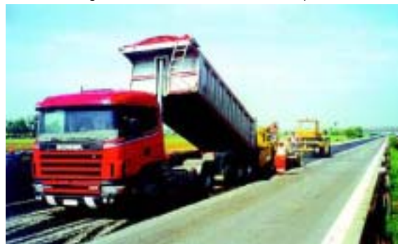
Compattazione dello strato rigenerato dopo la stesa in opera Stesa del conglomerato bituminoso della nuova pavimentazione
