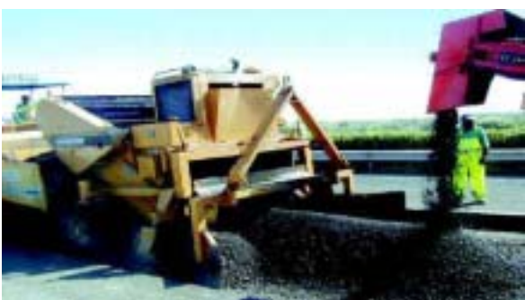
Stesa del riciclato con finitrice dotata di caricatore
