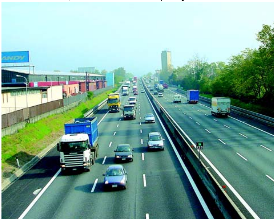
Veduta della A4 in corrispondenza dello stabilimento Candy di Brugherio
