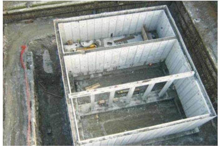
Particolari dello scavo e del montaggio della vasca di laminazione 3
