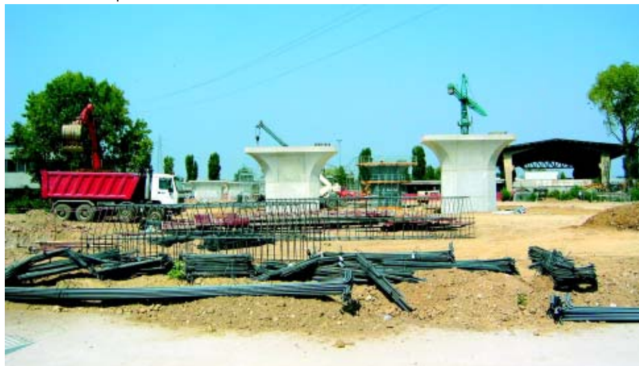
Costruzione delle pile del viadotto fra la A8 e la Fiera
