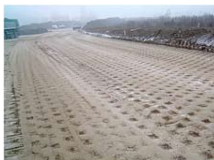
Particolare dei lavori di stabilizzazione del sottofondo, sezione tipo della pavimentazione stradale e, accanto, particolari della stesa e rullatura dello strato bituminoso superiore, realizzato con bitume modificato con Asphalt Rubber
