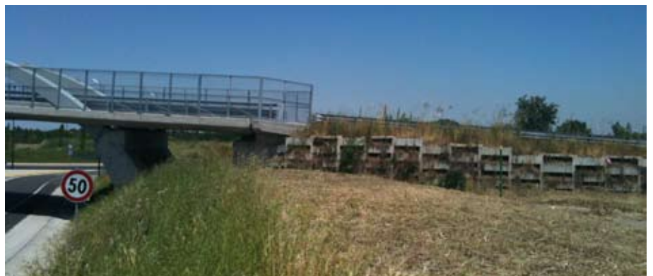
Prospetto, sezione e veduta dei paramenti dei rilevati dei ponti realizzati con elementi in calcestruzzo rinverdibili
