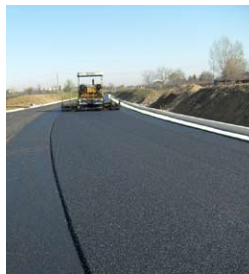
Particolare dei lavori di stabilizzazione del sottofondo, sezione tipo della pavimentazione stradale e, accanto, particolari della stesa e rullatura dello strato bituminoso superiore, realizzato con bitume modificato con Asphalt Rubber
