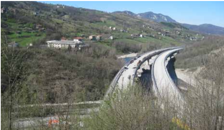
Panoramica del viadotto Lagaro nel lotto 5b.
