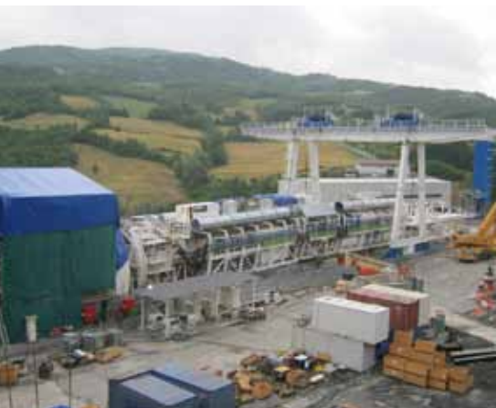
Montaggio della fresa che scaverà la galleria Sparvo, nel lotto 6-7
