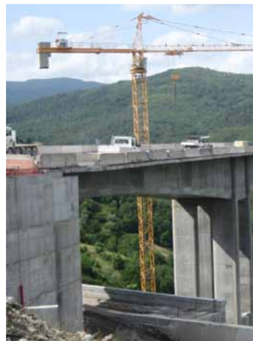
Veduta del viadotto Aglio, nel lotto 13
