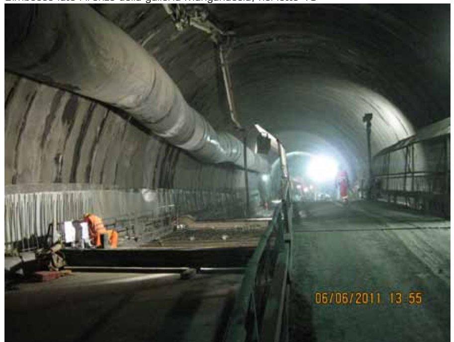
L'imbocco lato Firenze della galleria Manganaccia, nel lotto 13
