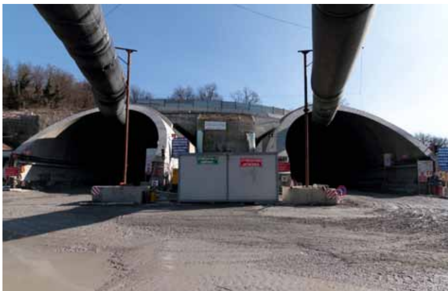
L'imbocco lato Bologna della galleria Grizzana, nel lotto 5a
