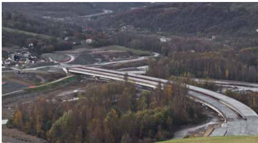
Interventi in corso nel lotto 5a, presso Riveggio: il viadotto Pian di Setta, e sotto, il ponte Rio Elle con l'imbocco della galleria naturale Riveggio
