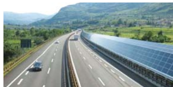
Veduta dei pannelli fotovoltaici installati lungo l'autostrada del Brennero
